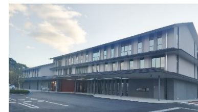
□ 御所市防災交流館 (奈良県御所市)
