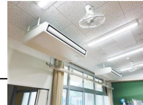
宮崎市小学校空調整備
