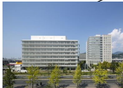
熊本合同庁舎B棟
