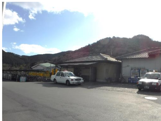
駅舎横トイレ 着工前
