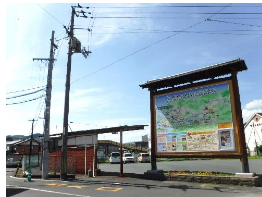
ロータリー 着工前
