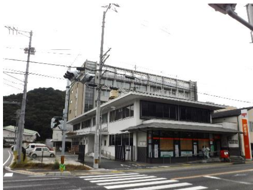
庁舎第二別館 着工前
