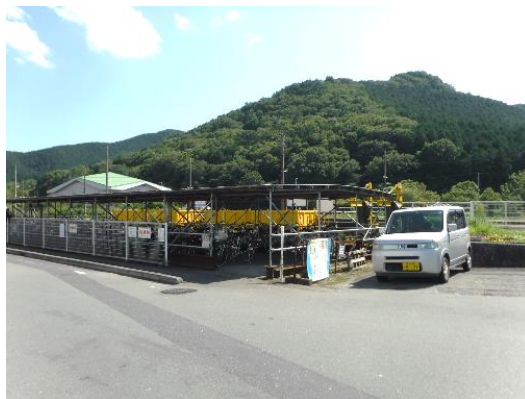
駐輪場 着工前
