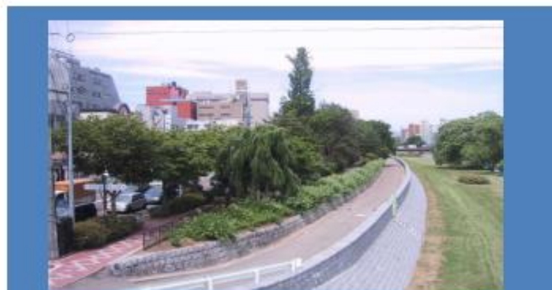
【再整備前】（平成26年ころ） 駅前だが公衆トイレがなく、樹木の繁茂により見通しが低下
