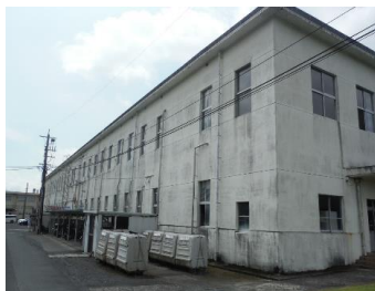
【現状施設の例(庁舎)】
