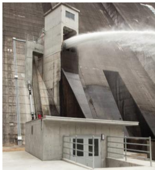
【発電設備の新設・増強】
