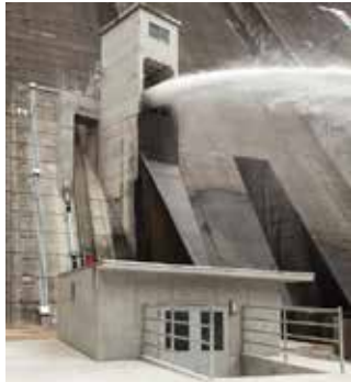
【発電設備の新設・増強】
