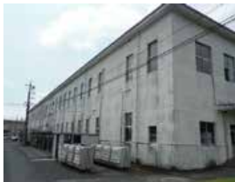
【現状施設の例(庁舎)】
