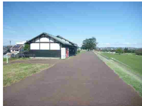
本堤拡幅部(休憩所付近)
