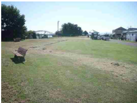
本堤拡幅部(木曾川橋側)
