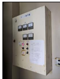
(引込開閉器盤) (動力盤)
