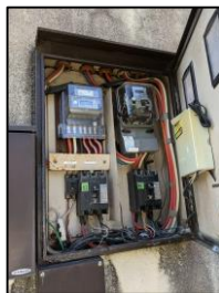
(引込開閉器盤) (動力盤)
