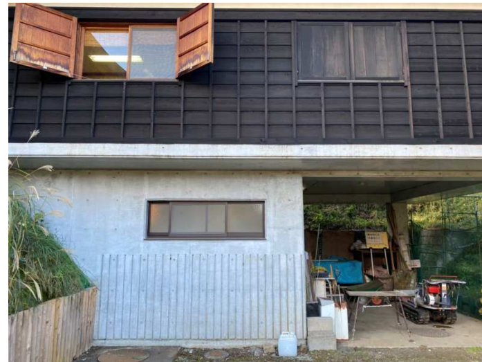
ふれあいの館 倉庫
