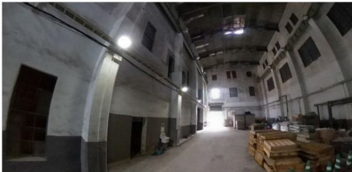
図表 52 志津川発電所 川側1スパン部分の内観
