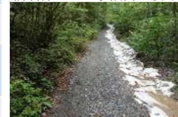
大雨により削れた道路の補修
