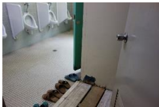
入口に段差があり、バリアフリー対応とはなっていない。
