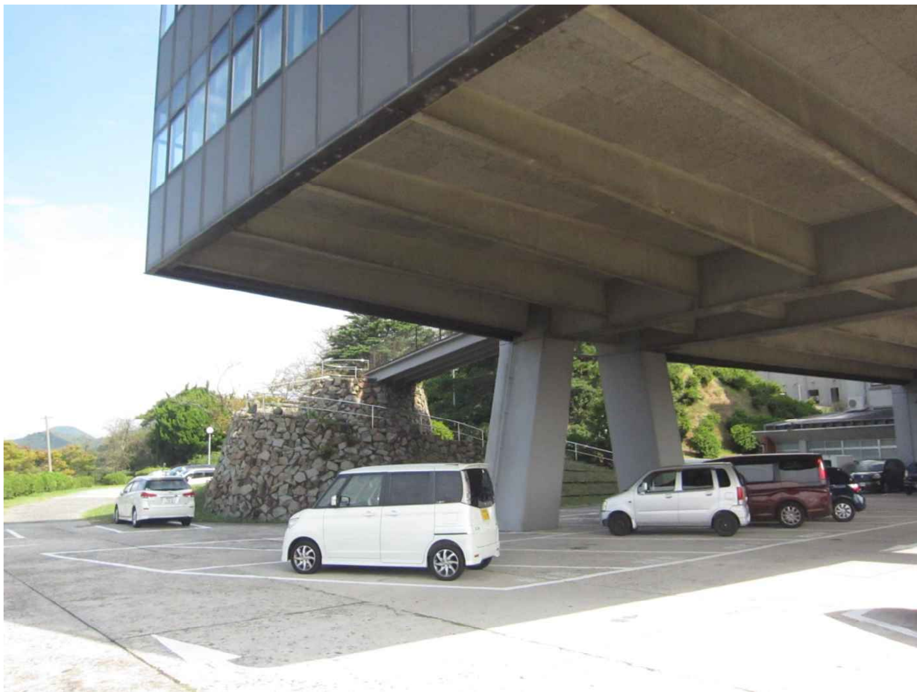
丸子山公園（A棟下から駐車場方向）
