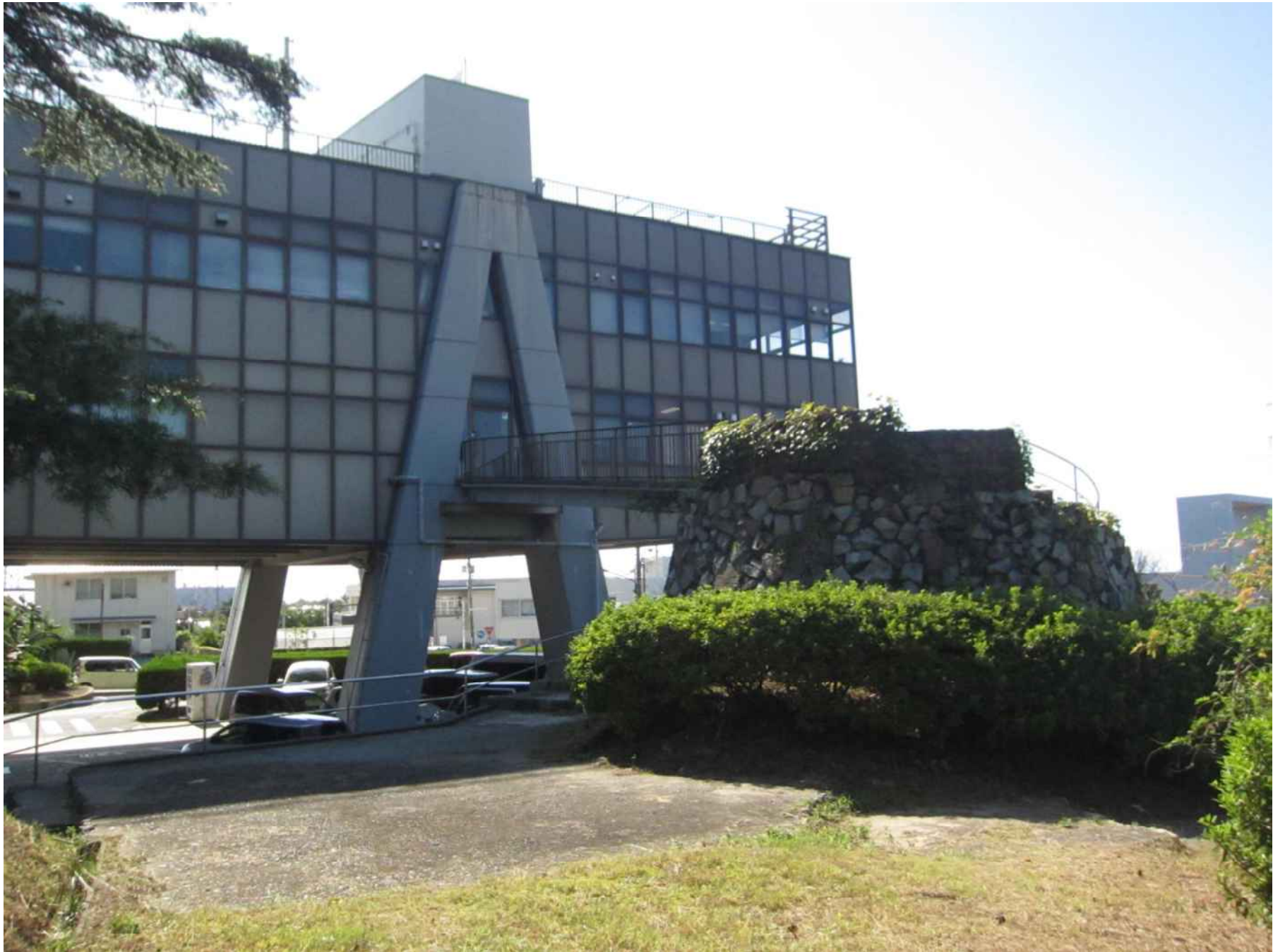
庁舎東面（A棟）
