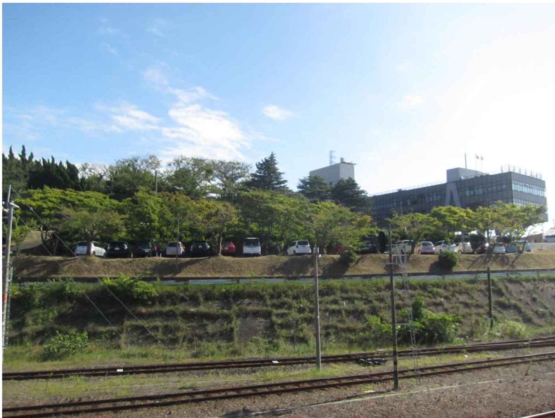
遠景（庁舎東面）
