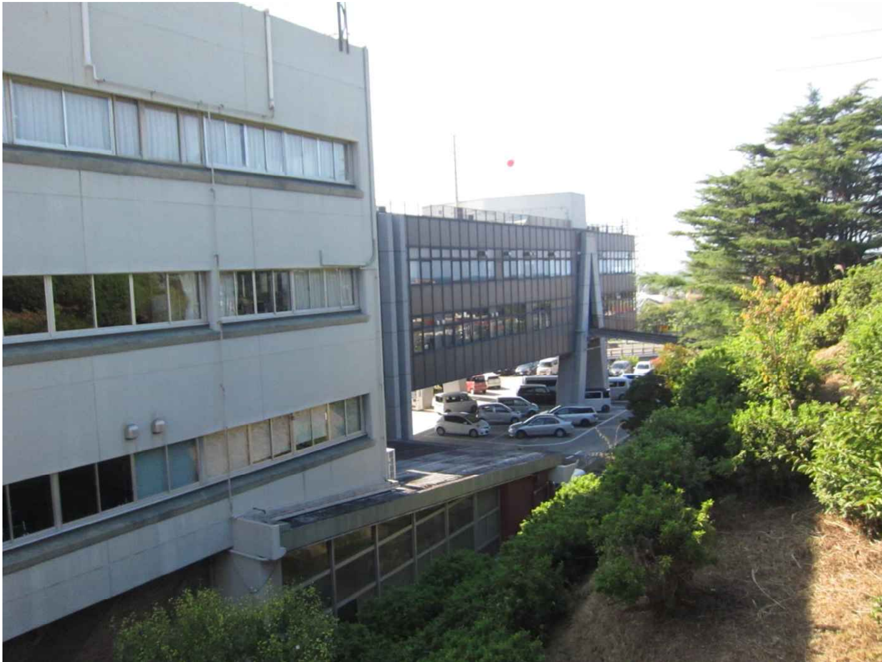
庁舎東面（手前：B棟、奥：A棟）
