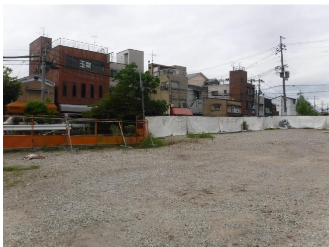
写真1 住市総⑥南東側から計画地を撮影
