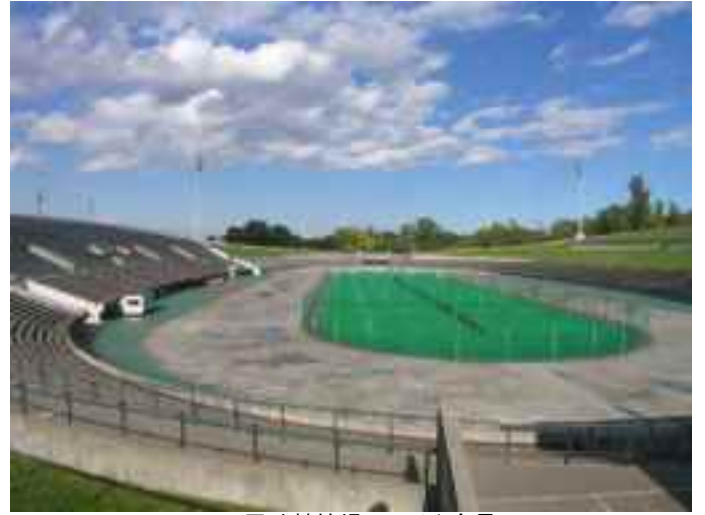
02 屋外競技場フィールド全景
