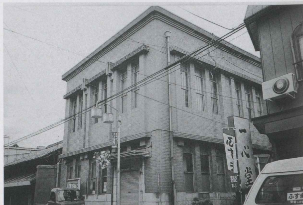
旧中部電力稲沢営業所
