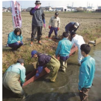
④ 集落総出で魚道を設置
