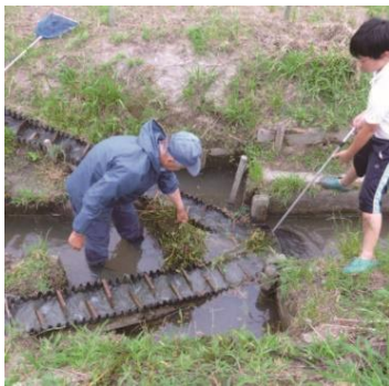
① 水路と水田を結ぶ水田魚道
