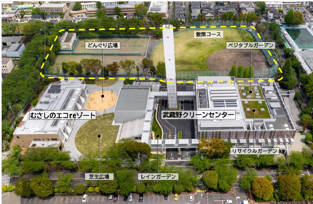
「まちとつながる」施設として建替えられた清掃工場
