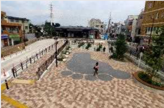
世田谷代田駅駅前広場の足あとシンボルに透水性舗装のほか、一部範囲に雨水貯留型ブロックを採用
