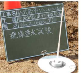
現地透水試験
