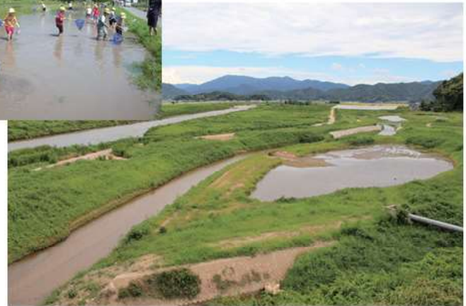
大規模湿地再生事業で整備された加陽湿地
