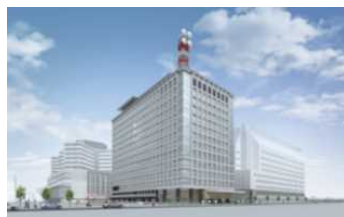
【大阪第6地方合同庁舎(仮称)】
