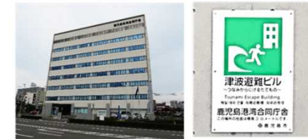
(鹿兒島港湾合同庁舎)津波避難ビルの機能を確保
