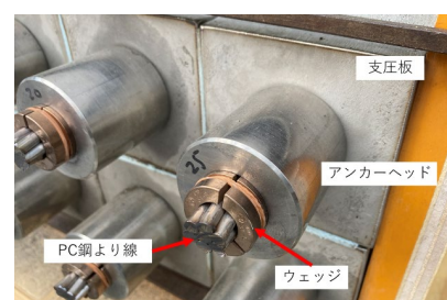
写真1 ステンレス製シングルストランド用 PC 定着具
