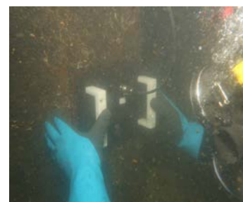
図1. 大型磁気センサプローブを用いた水中部検査
