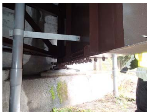
写真-5.5 桁端部補修塗装
