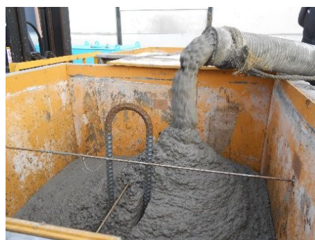
写真-2 圧送状況（筒先）ケース6
