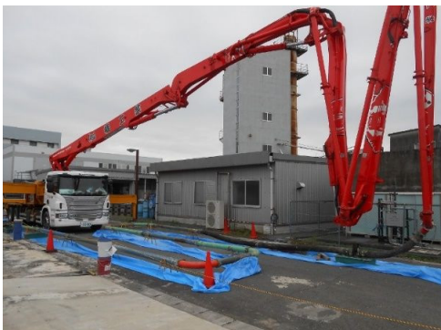
写真-1 圧送試験状況
