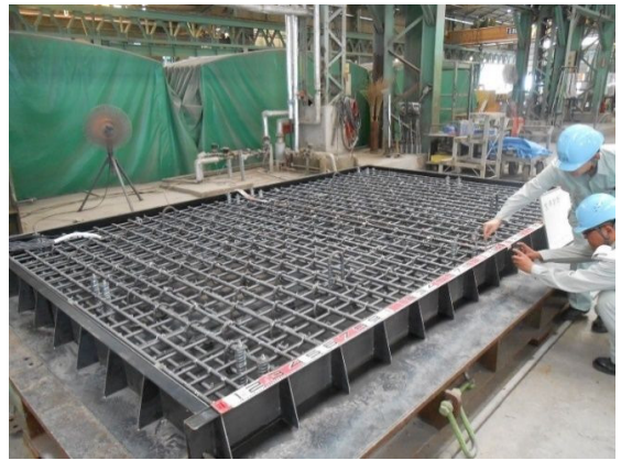
写真-5 供試体作製状況 (打設前)
