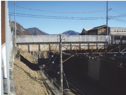
写真-2.1 電化区間の跨線橋
