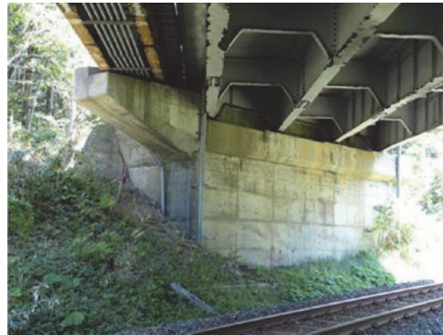
写真-2.2 非電化区間の跨線橋
