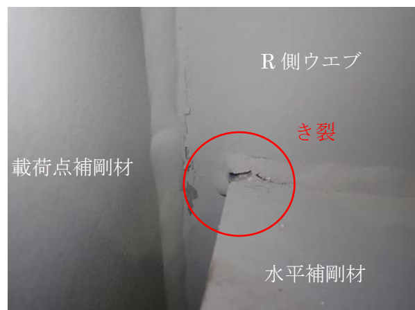
(b) R側パネル：水平補剛材の支間中央側端部
