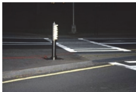
図2-1 Midblock横断歩道への新型照明装置の試験設置例
