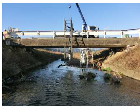
写真 1.2 実橋での設置状況
