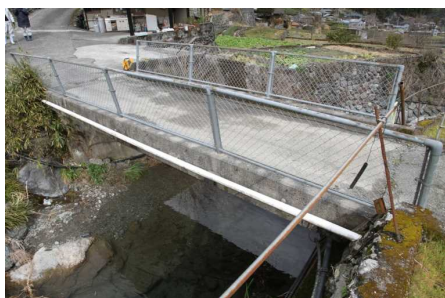
図2.2 高知県仁淀川市無名橋
