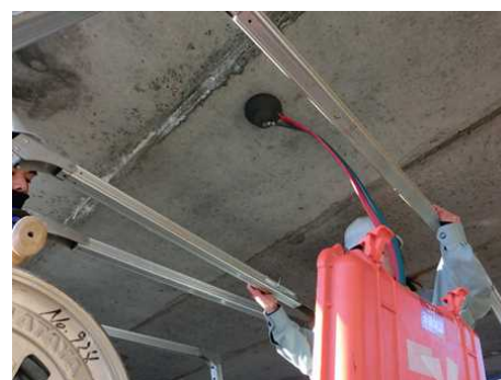
写真 1.4 透気試験の状況
