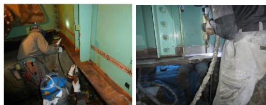
写真6 左：2種ケレン状況，右：CS施工
