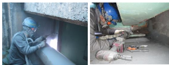
写真7 (c) 支点補剛材 (d) 支承部
