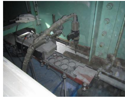
写真8 半自動化施工状況
