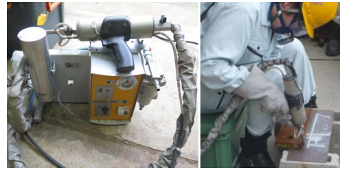
写真1 低圧低温型CS機械と施工状況
