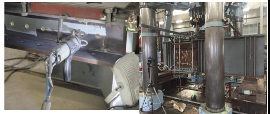
写真11 CS施工(左)と大型試験装置(右)
