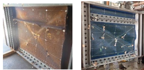
写真13 実験後のせん断座屈状況 (左: 当板, 右: 炭素繊維)
