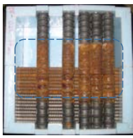
コンクリート打設前の配筋例 D22とD6の組み合わせ 中央部分に塩水でさび生成(点線内部の領域)
