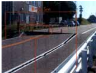
写真-2.1.1 段差被害の差異の事例：2004 新潟県中越地震（国道 17 号石田南平 2) ）
