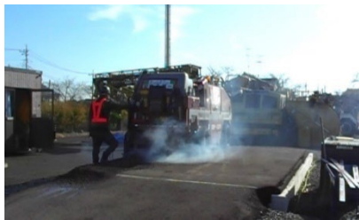
写真 2-5 5m 道路切削状
