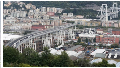
伊・モランディ橋崩落事故 (2018.8.14)
