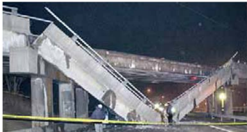
米国・I-70跨道橋落橋事故 (2005.12.28)
