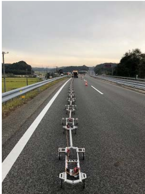
写真 2-1 2次元表面波探査測定状況
