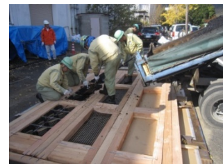
(c) アスファルト混合物の投入
