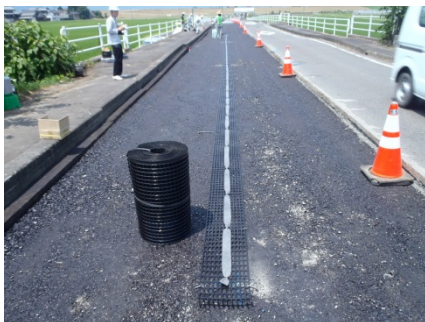
写真 c-4 ジオグリッドセンサの敷設の状況
