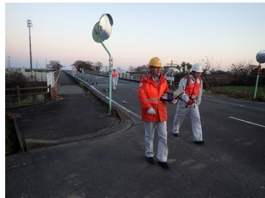
写真 1-2 牽引式電気探査測定状況
