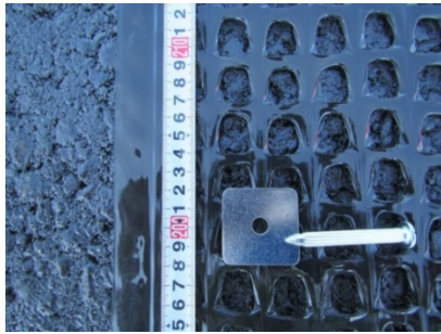
3) ジオセルの組立設置
