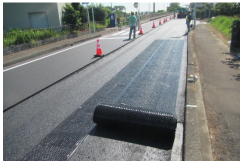
6) アスファルト補強ジオグリッドの固定
