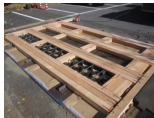
(b) ジオテキスタイルの設置
