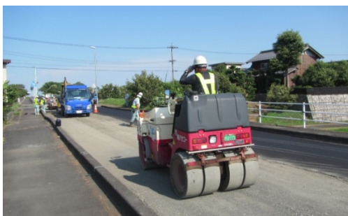
5) 振動ローラ、タイヤローラによる転圧
