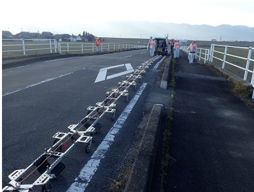
写真 1-1 2次元表面波探査測定状況
