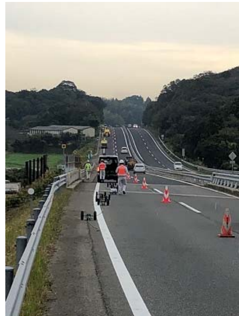
写真 2-2 牽引式電気探査測定状況
