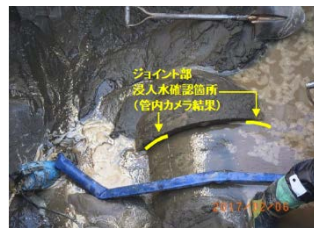
空洞の開削調査 合流管 (Φ800, GL-1.64m)
