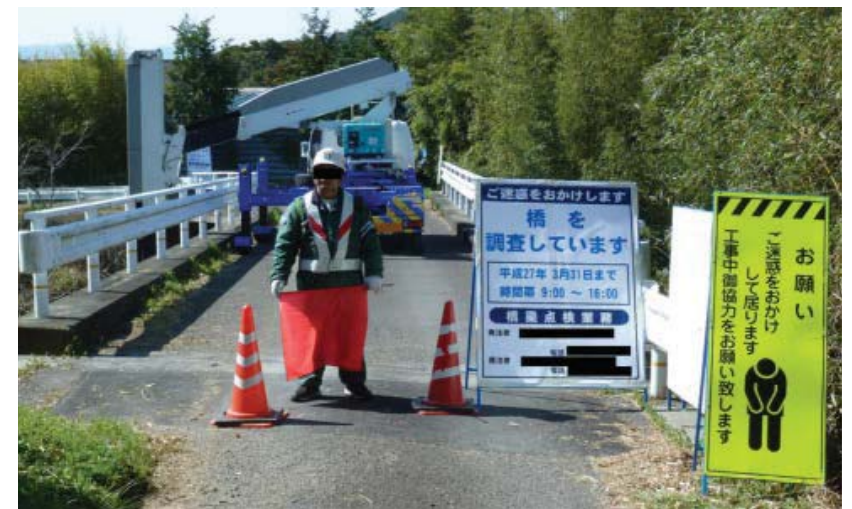
有効幅員4.0mの橋梁の点検状況
