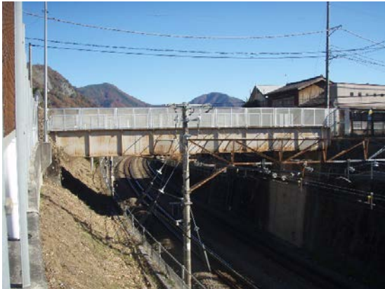
写真-1 電化区間の跨線橋
