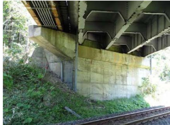
写真-2 非電化区間の跨線橋
