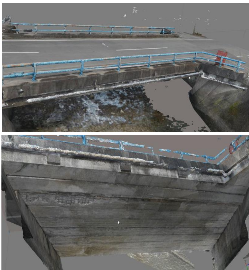
図 3.3 橋梁 3 次元復元結果
