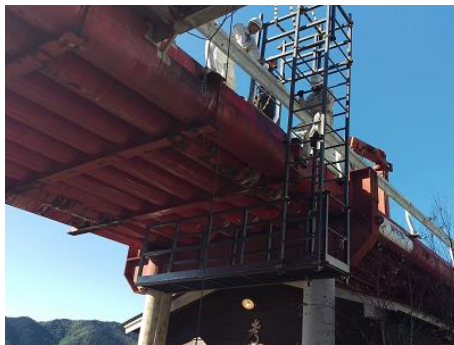
写真 1.2 作業員の昇降
