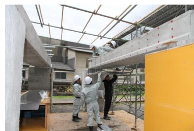
写真 2.1 電食試験・計測を行った RC 梁とその設置状況
