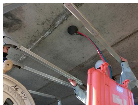
写真 1.8 透気試験の状況
