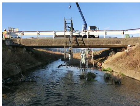
写真 1.6 実橋での設置状況
