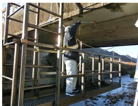
写真 1.7 打音検査の状況
