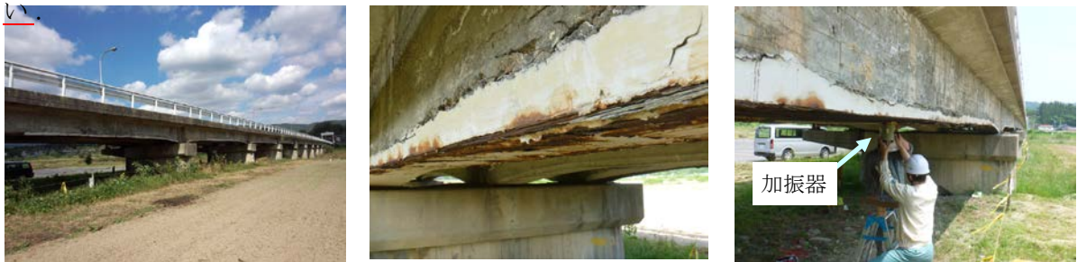
(a) 橋梁の全景
