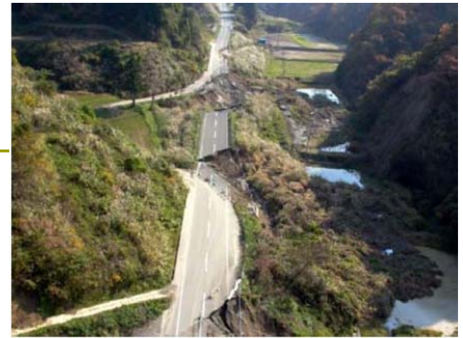
2004年新潟県中越地震での道路盛土崩壊 (国土技術政策総合研究所・土木研究所, 2006, 1)
