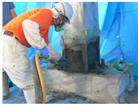
吹付けの状況
