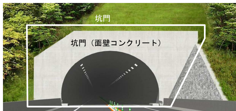
定期点検対象箇所の例（トンネル坑口部）
