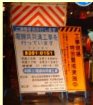
【 工事看板の設置例 】
