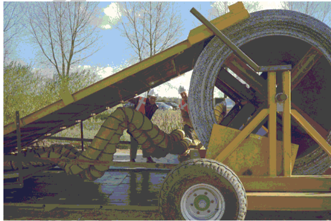
The Roll-Out Road : ( 超低騒音ロール舗装 )
