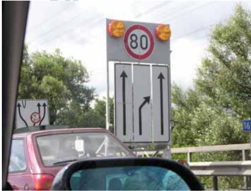
ドイツ・アウトバーンでの Contra-Flow の例 (速度規制、車線誘導の標示)
