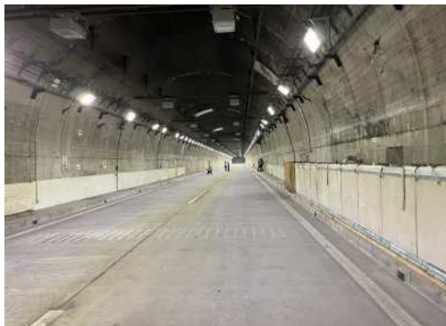
トンネル状況
