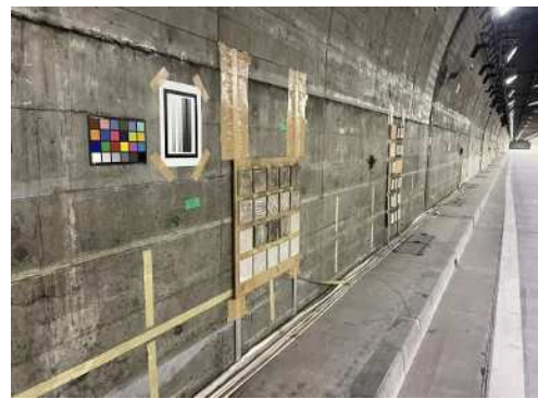
試験体設置状況
