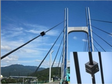
測定状況の例
