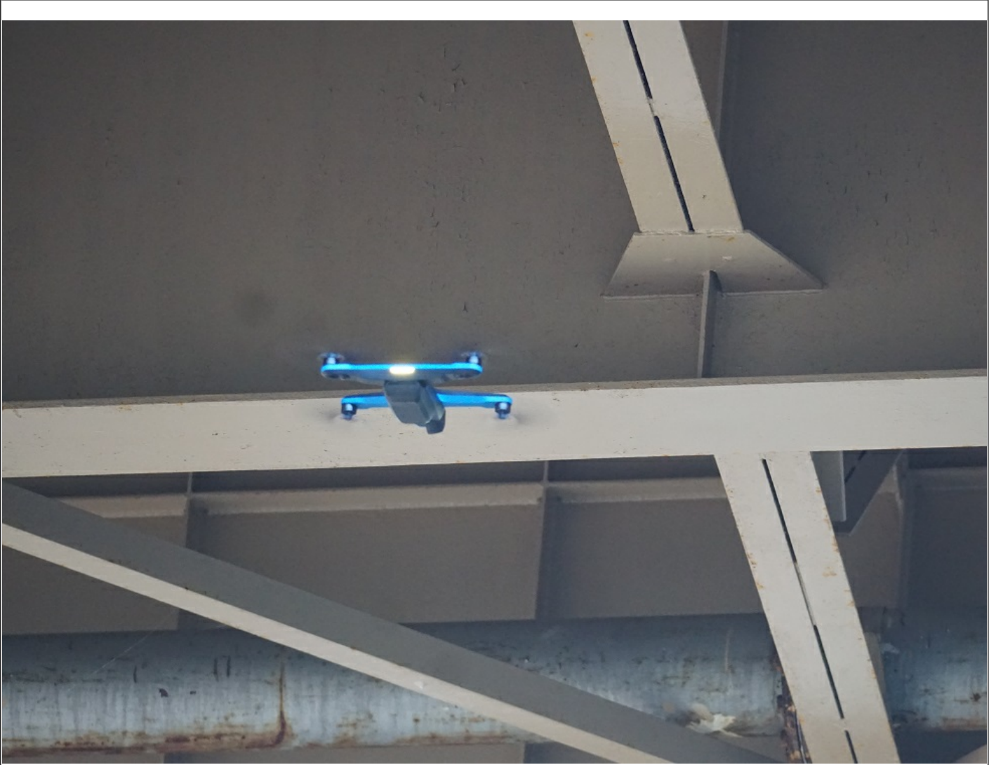
図3 Skydio 2による点検状況
