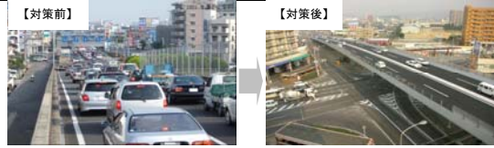
【松山市小坂高架橋開通(平成19年2月4日)】
