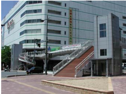
エレベーターの設置された 立体横断施設の例
