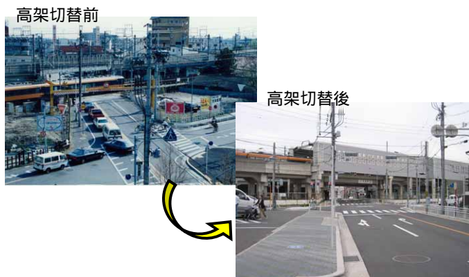
図 10-2 烏森第 1 号踏切の高架切替前後の状況
