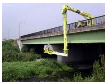
橋梁点検車による点検
