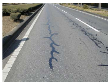
舗装の予防的修繕工法の施工事例
