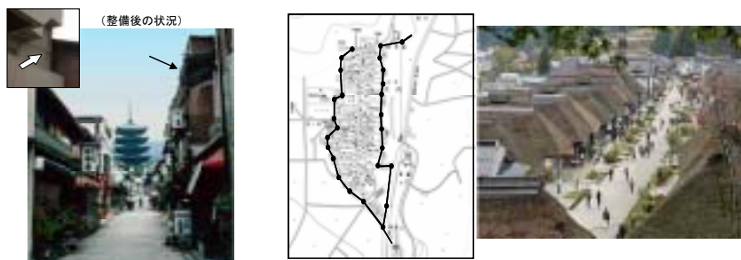
(軒下配線事例 京都八坂通)
