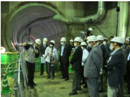
品川線トンネル工事現場
