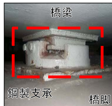
旧型の鋼製支承
