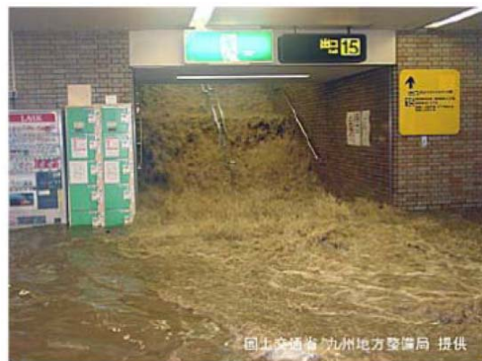
H15年 地下街の浸水状況(福岡県) 出典:国土交通省九州地方整備局
